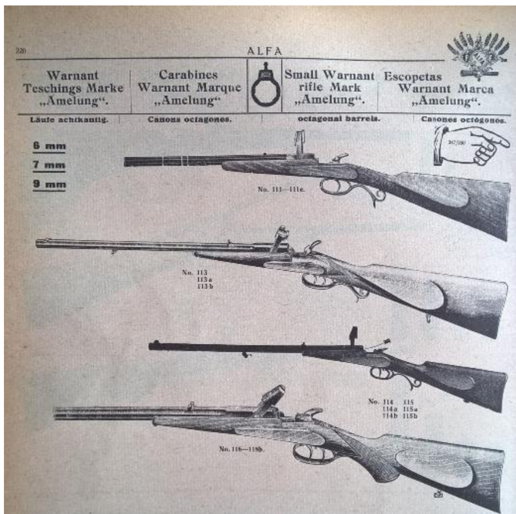
Afbeelding 2.04B Flobert geweren met een Warnant sluiting. De wapens werden geleverd in kal. 6 mm, 7 mm en 9 mm Flobert, zoals dat linksboven in de afbeelding is te zien.
