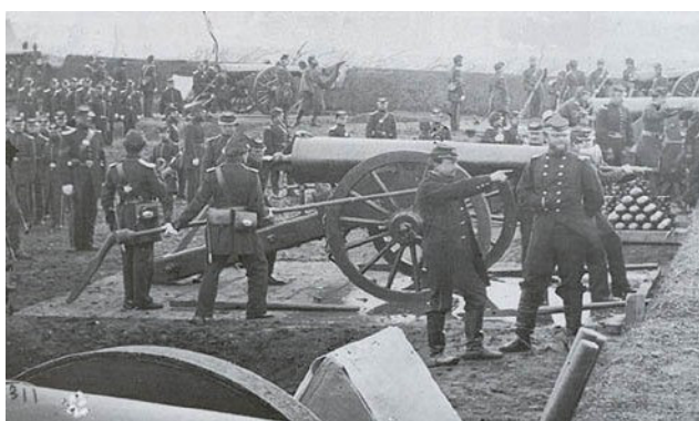
Afbeelding 3.6 Whitworth voorlaadkanon zoals dat in gebruik was tijdens de Amerikaanse Burgeroorlog. Dit kanon had een effectief bereik van 6 miles (9,6 kilometer). 1 bron vermeldt dat deze lopen zo sterk waren door de toepassing van Fluid Compressed Steel, ontwikkeld door Whitworth. Foto gepubliceerd met toestemming van Jack Melton Jr.
