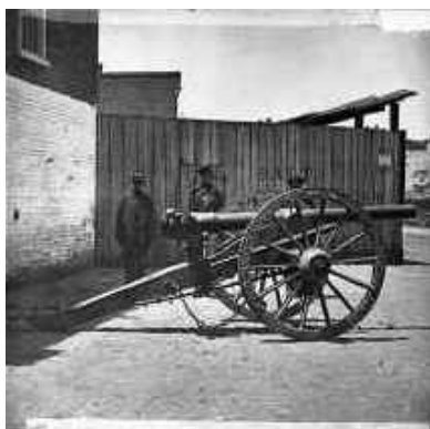
Afbeelding 3.7 Whitworth achterlaadkanon zoals dat in gebruik is tijdens de Amerikaanse Burgeroorlog. Het sluitstuk is zichtbaar als de verdikking aan de achterzijde van de loop. Foto gepubliceerd met toestemming van Jack Melton Jr.
