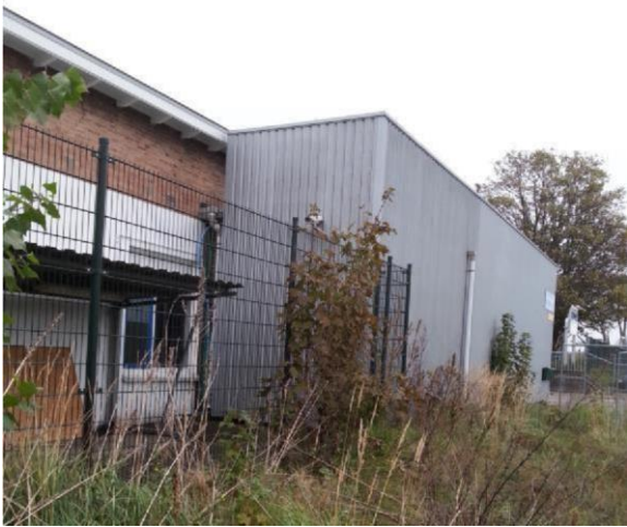
Afbeelding 14. De kogelvanger is nu bekleed met grijze profielplaat
